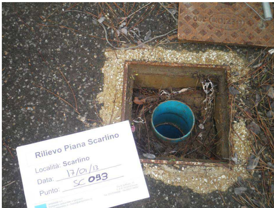
Figura 19: Esempio Rilievo fotografico con verifica della condizione del piezometro
